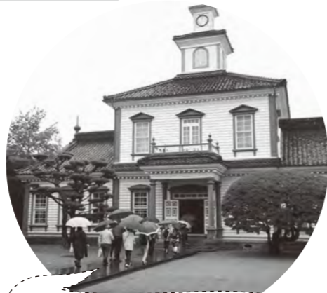
歴史的建造物めぐりの様子...旧西田川郡役所 初代県令三島通庸の命により建築。棟梁は鶴岡の大工町(現在の陽光町)に生まれた高橋兼吉。兼吉は、荘内神社殿や湯田川の由豆佐売神社など寺社建築のほか、庄内地方に現存する多くの洋風建築物を建てました。
