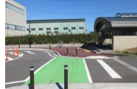
20.鶴岡駅地下通路北側入口前
